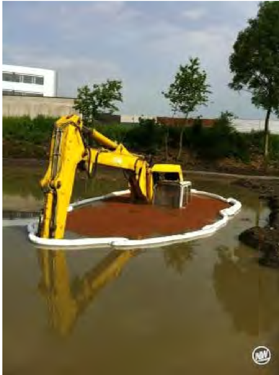
Künftiges Regenrückhaltebecken Finkenbach
