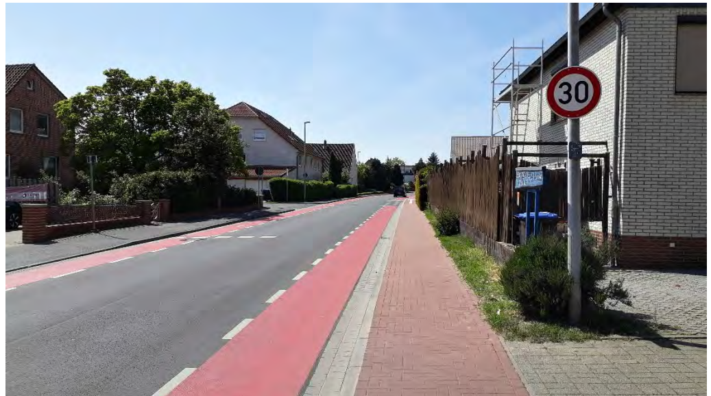
Abb. 25 Eingefärbte Schutzstreifen in Kombination mit Tempo 30 in Harenberg (Seelze) 12
