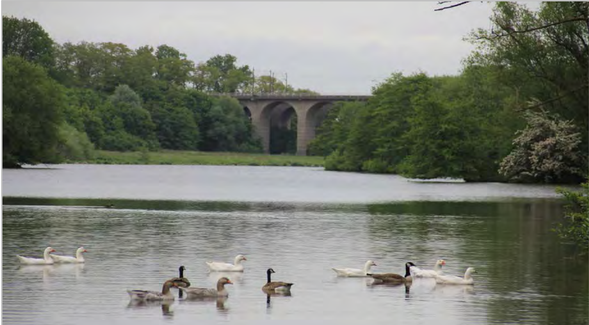
Abb. 22: Blick vom Südufer über den Obersee in Richtung Viadukt
