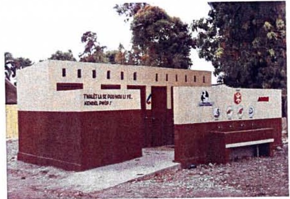
Der neue Toilettenblock des „College Isaac Berde“.
