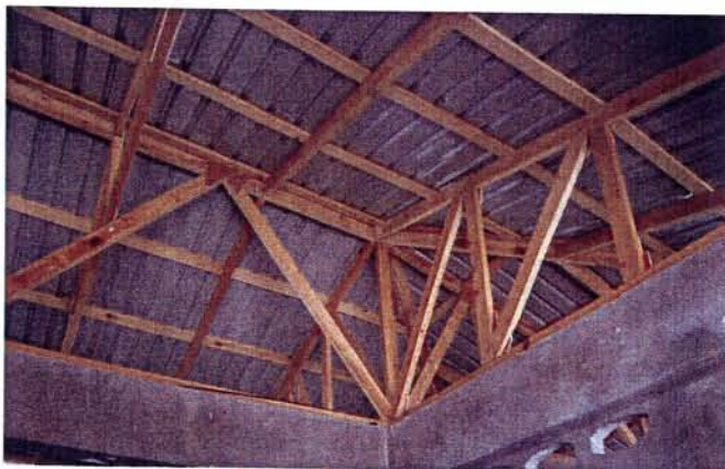
Bauarbeiten am Dach der neuen Schule.
