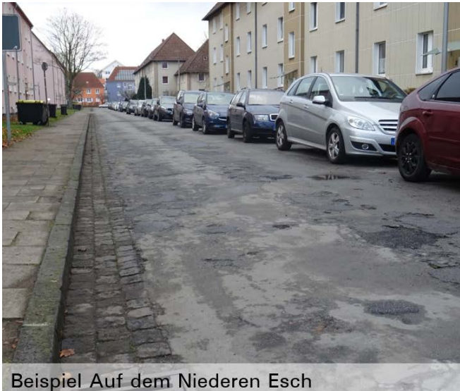
Abb. 34 Beispiel von schadhafte Fahrbahnoberflächen
