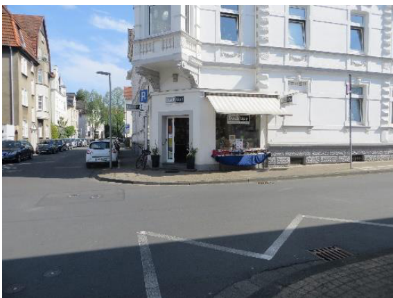
Abb. 8: Fehlende Bordsteinabsenkung (Siegfriedstraße)
