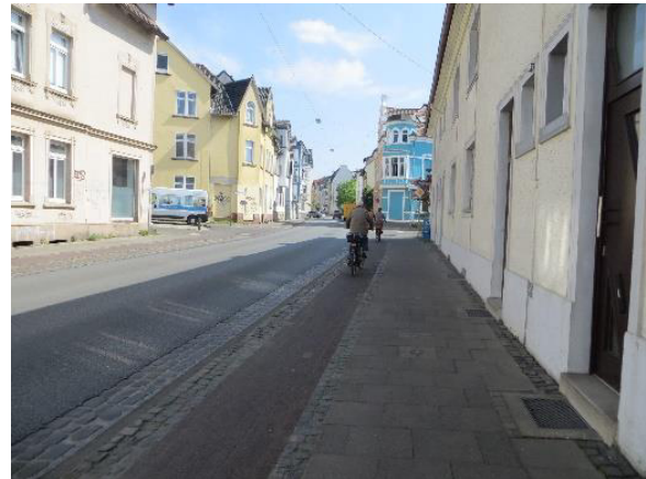
Abb. 122: Baulicher Radweg (Schloßhofstraße)
