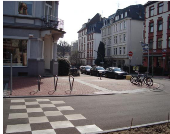
Abb. 61: Fahrradabstellanlagen im vorgezogenen Kreuzungsbereich in Frankfurt-Nordend
